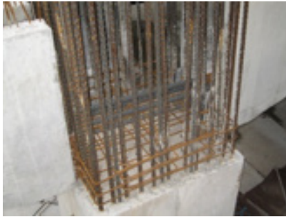
Foto 3. Conexión emulativa del concreto reforzado.
